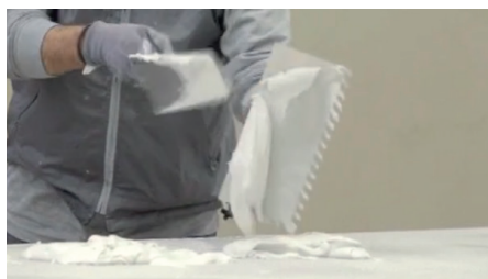
Spatule dotée de dents inclinées de 10 mm
